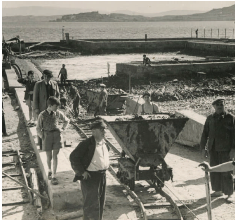
Ouvriers et bénévoles travaillant à l'aménagement du port de la Nautique, vers 1950-1960 © Droits réservés
