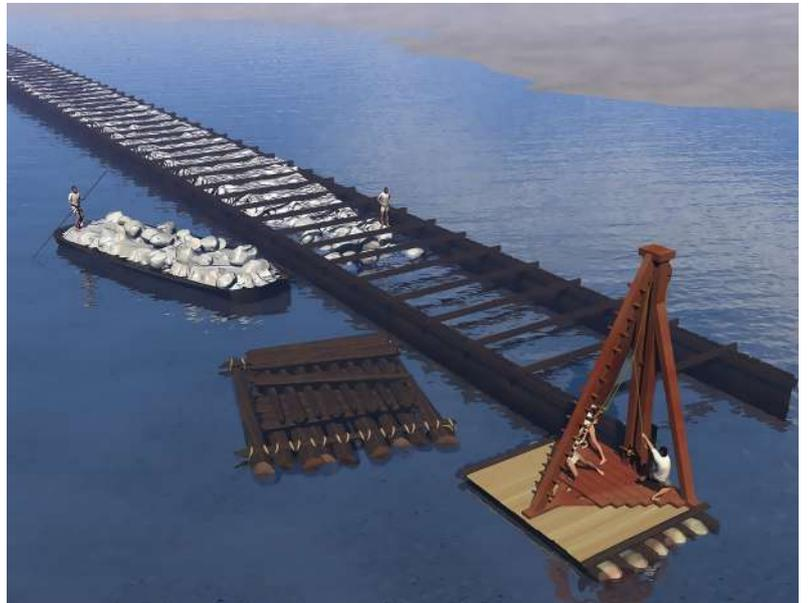
Construcción de diques para canalizar el Aude en Mandirac © P. Cervellin, CNRS
