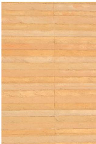
Au musée Narbo Via, les murs sont en béton coloré grâce à des oxydes. Cette couleur rappelle les couleurs des terres méditerranéennes (ocres) mais aussi le mortier de tuileau romain. Ce béton a été coulé par couches dans des coffrages puis
