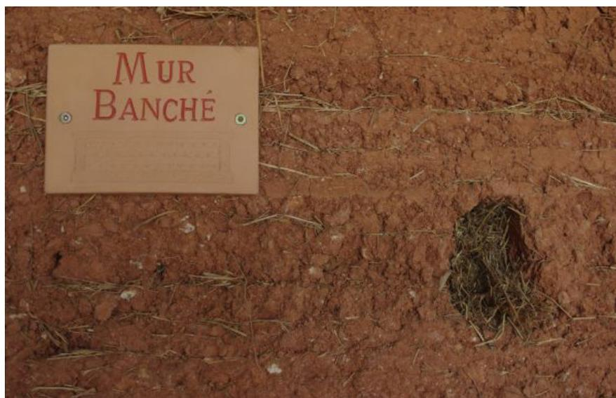
Le mur banché est réalisé grâce à un coffrage en bois.
